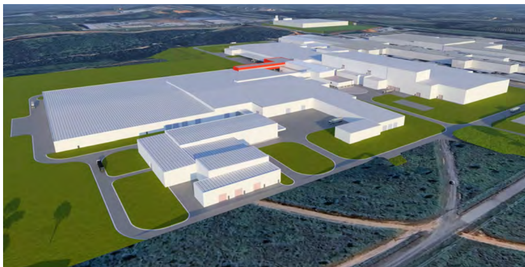
Projeto do novo complexo da Toyota em Sorocaba: novos produtos e mais nacionalização.
